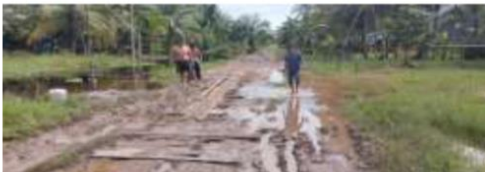
Gambar 1 Gotong royong Dusun Kasih perbaikan jalan rusak
